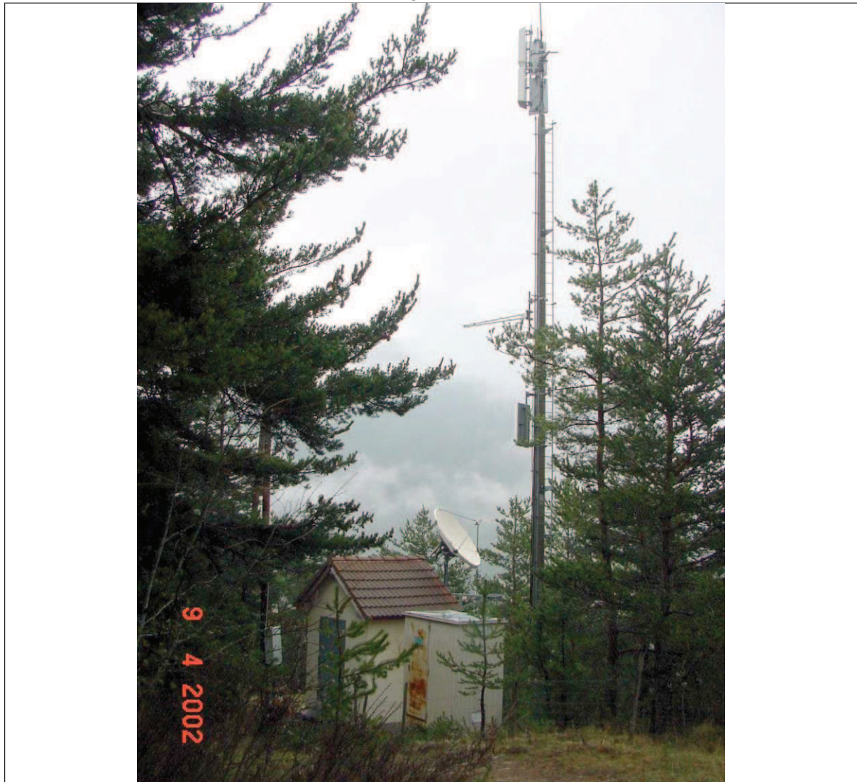
Vue générale du site
