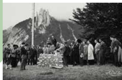
Pose de la première pierre de la nécropole du cimetière de Saint-Nizier-du-Moucherotte, juillet 1946.
