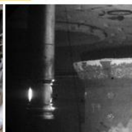
La carbonatation de la cuve pour supprimer le sodium
