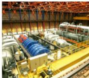
Le démantèlement de la salle des machines
