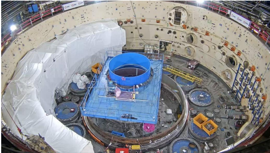
Plateforme de retrait du bouchon couvercle cœur
