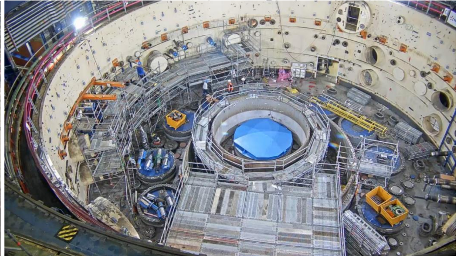
Plateforme de retrait du petit bouchon tournant
