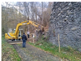
Pendant les travaux
