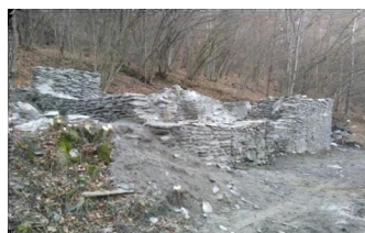
Après les travaux
